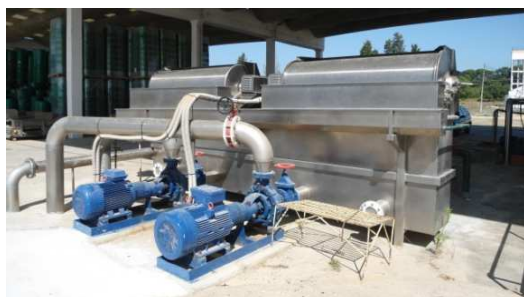
Figura 16 – Registo fotográfico do sistema de bombagem [BMTRA01 E BMTRA02] e dos tamisadores [TMRA01 E TMRA02] afetos às reutilizações de águas n.º 2 e n.º 3
