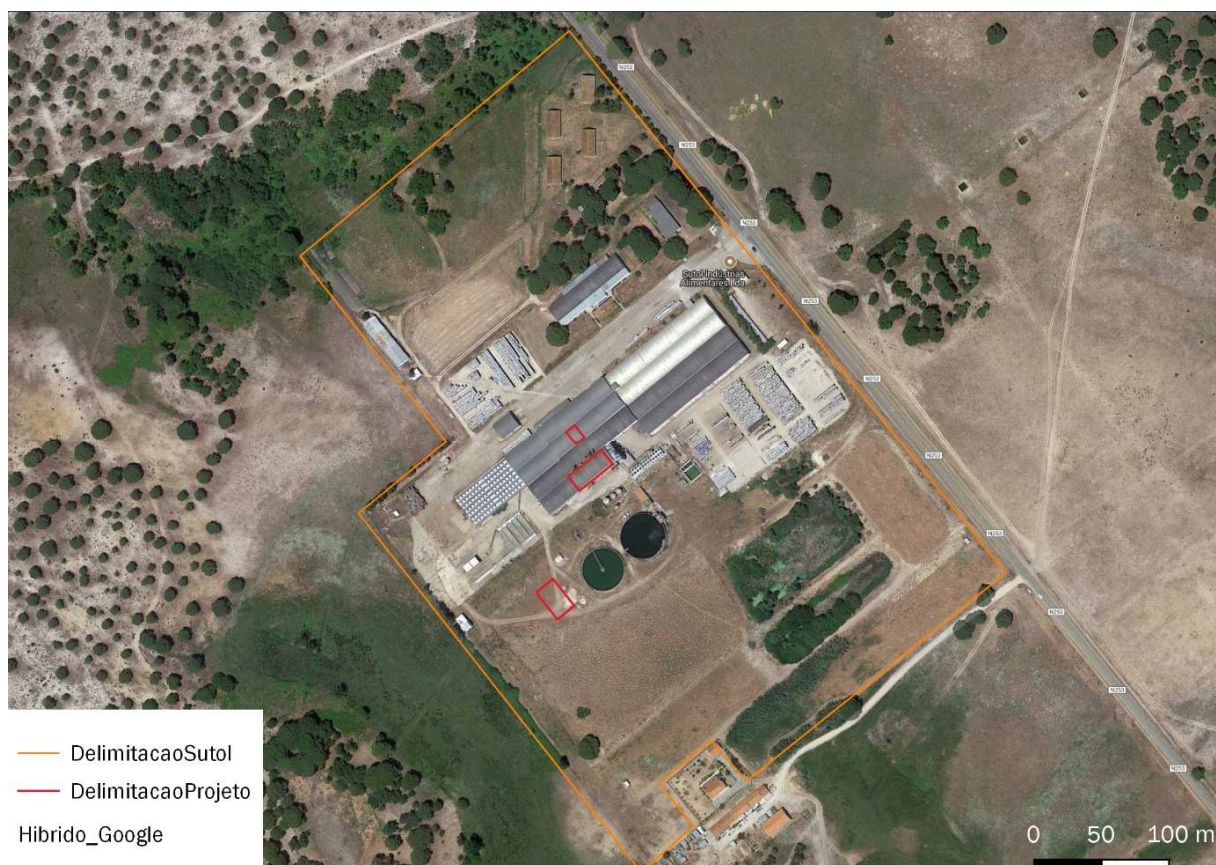
Figura 8 - Vista geral do estabelecimento industrial
