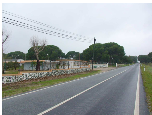
Figura 14 - Vista geral do acesso ao Estabelecimento
